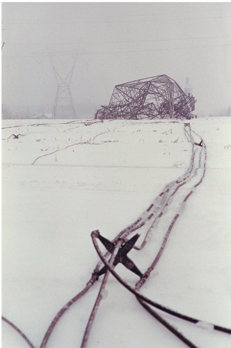
Après les tempêtes de glace au Québec en 1998. Photo Hydro-Québec
