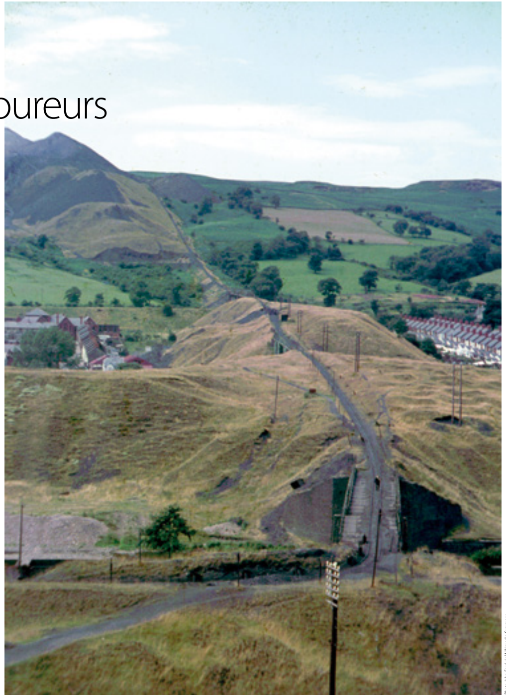
Aberfan en 1964 avec, à gauche, le groupe de bâtiments qui sera touché par l'effondrement du terril n° 7. Au centre, le système de transport des résidus par câble.
